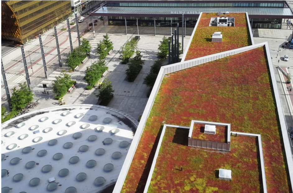
Figur 3 Exempelbild av ett sedumtak. Bild från Veg Tech (Veg Tech, 2020).
